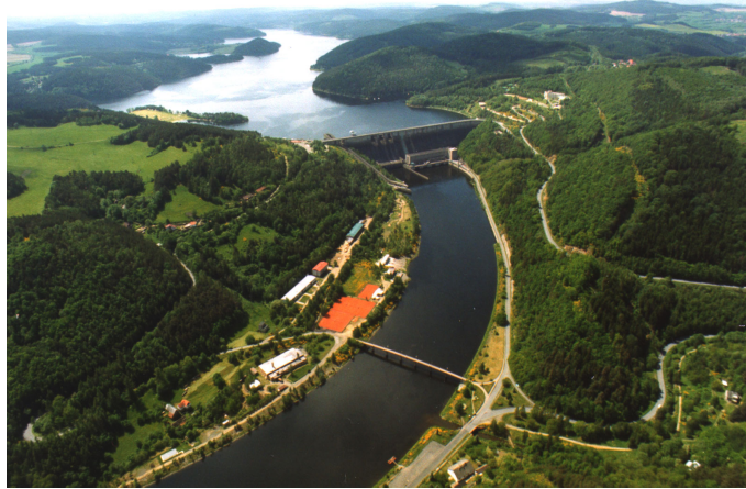
Obrázek 4.18: Vodní elektrárna Orlík [6]
