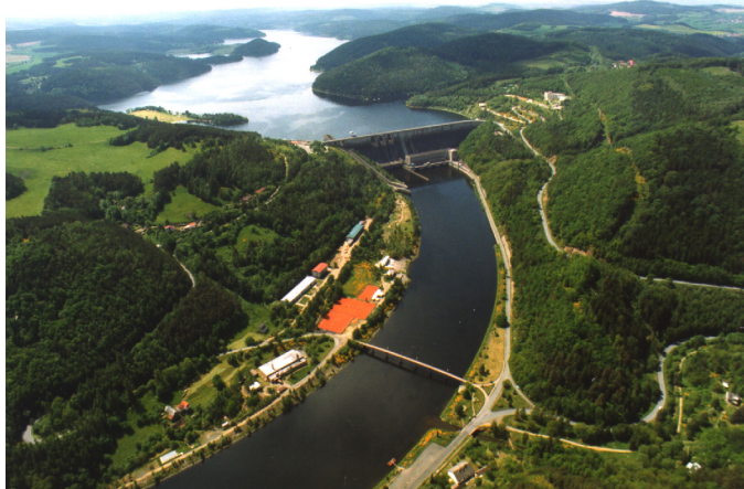
Obrázek 4.18: Vodní elektrárna Orlík [6]
