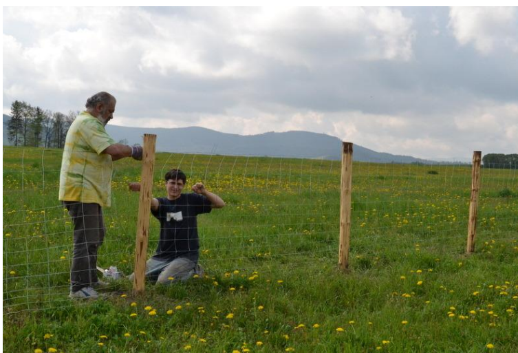
Obrázek 11: Stavba ohradníku
