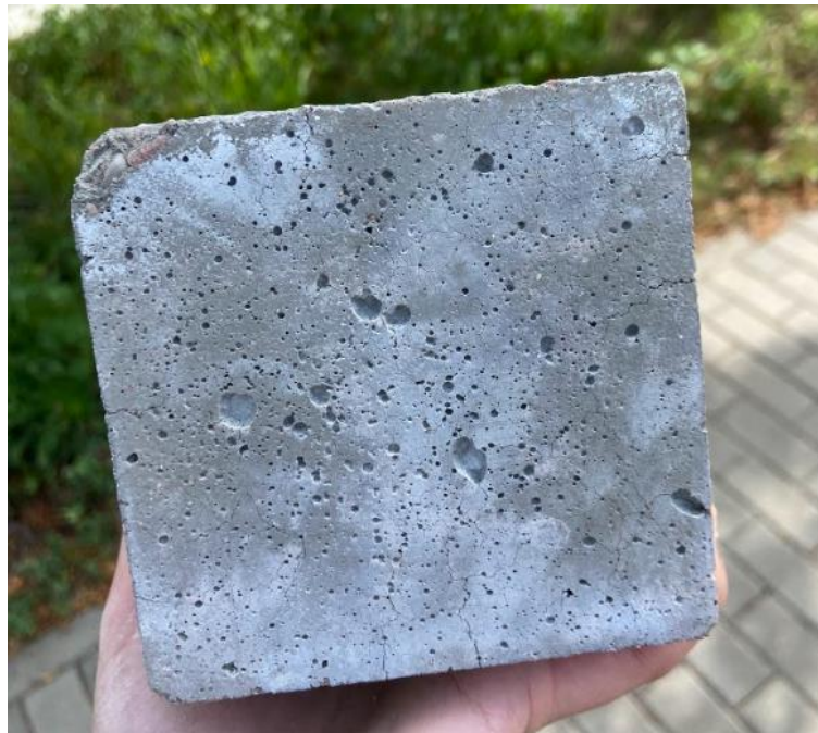
Obr. 22 - Detail porušení RECEPTURY 3
