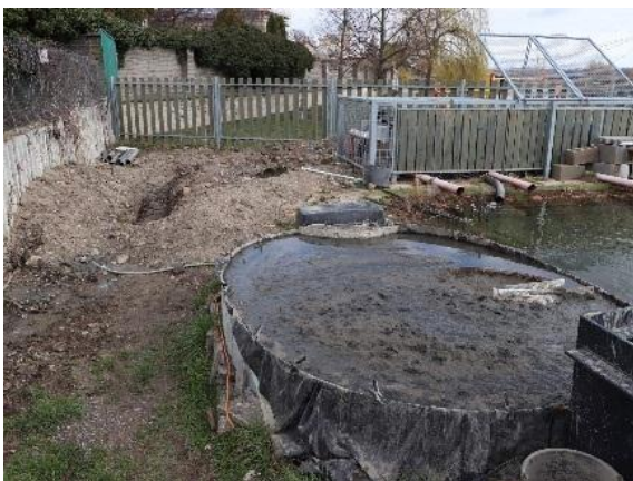
Obr.146: Přípravné výkopové práce na zapuštění nové kalové jámky, 14.3. 2019
