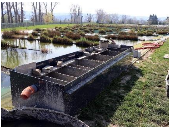
Obr.148: Nové sedimentační nádrže, 5.4. 2018
