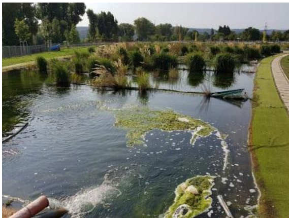
Obr. 75: Pohled na čistící jezero od jeho začátku, 8.9. 2017
