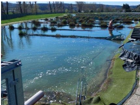
Obr. 77: Pohled na čistící jezero od jeho začátku, 14.4. 2018
