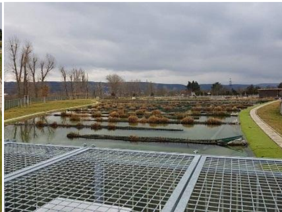
Obr. 76: Pohled na čistící jezero od jeho začátku, 14.3. 2018
