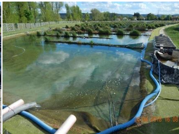
Obr. 78: Pohled na čistící jezero od jeho začátku, 26.4. 2018
