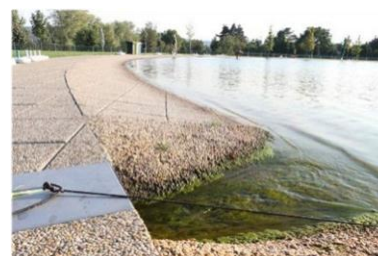
Obr 25: Jeden ze čtyř skimmerů odvádějících nečistoty z hladiny, biotop Radotín
