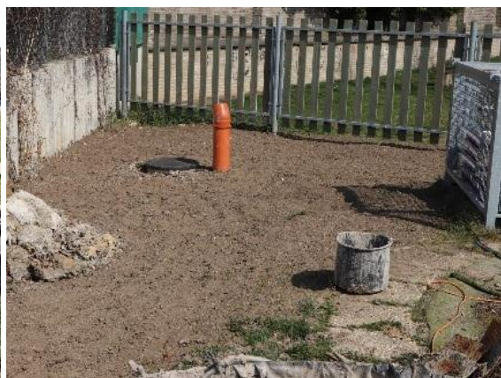
Obr.149: Nová jámka na kal je již zasypana zeminou, 5.4. 2018
