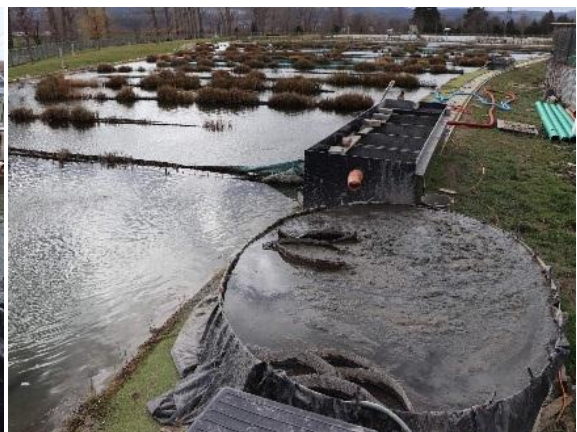
Obr.147: Pohled na čistící jezero od jeho začátku, 14.3. 2019
