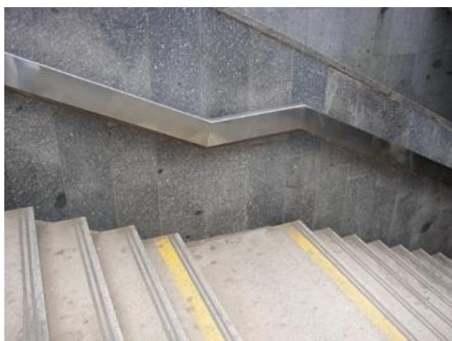
Obrázek 15. Schody označeny reflexním pásem ( http://bariery.centrumpronevidome.cz/bariery/vizualni.htm )
