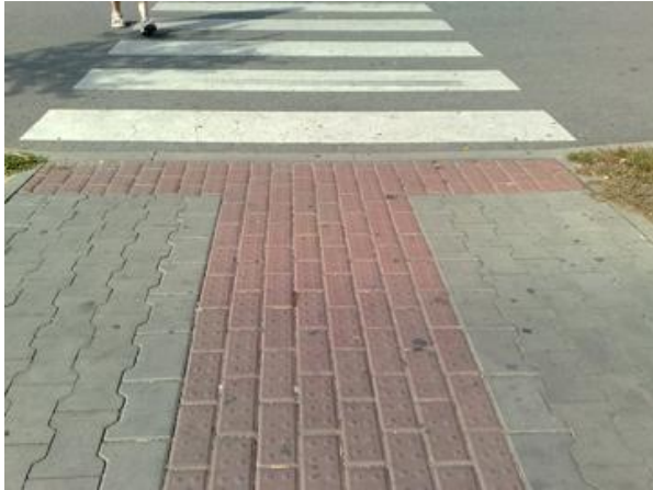
Obrázek 12. Signální pás ( http://bariery.centrumpronevidome.cz/bariery/hmatne.htm )
