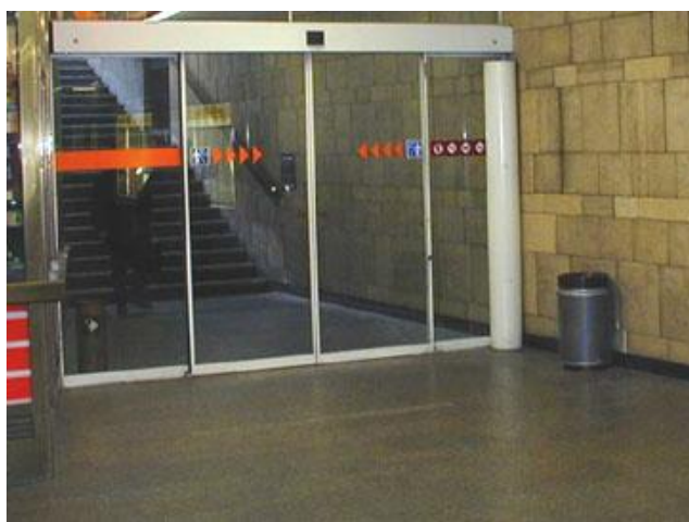
Obrázek 14. Prosklené dveře označeny kontrastním pásem ( http://bariery.centrumpronevidome.cz/bariery/vizualni.htm )
