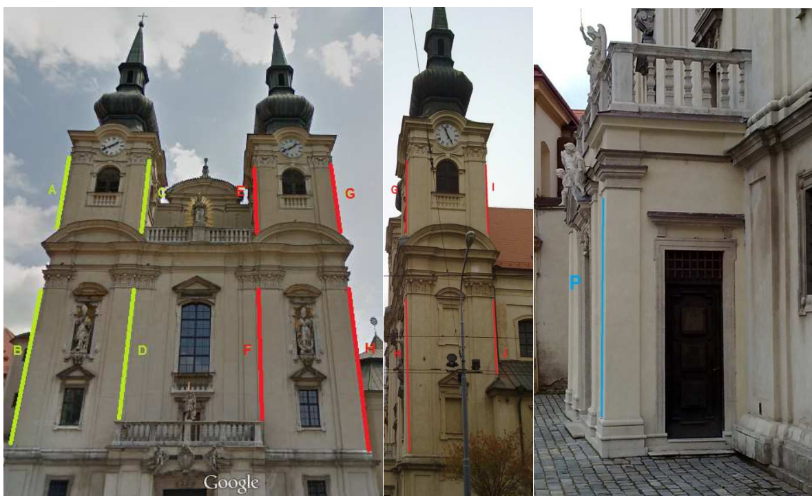
Obr. 19 Hrany na věžích kostela z čelního pohledu
