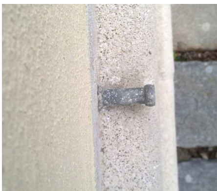
Obr. 7 Stabilizace pozorovaných bodů
