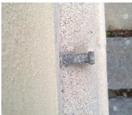
Obr. 7 Stabilizace pozorovaných bodů
