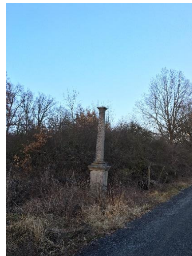
Obr. č. 21: Poškozená boží muka (č. 22)
