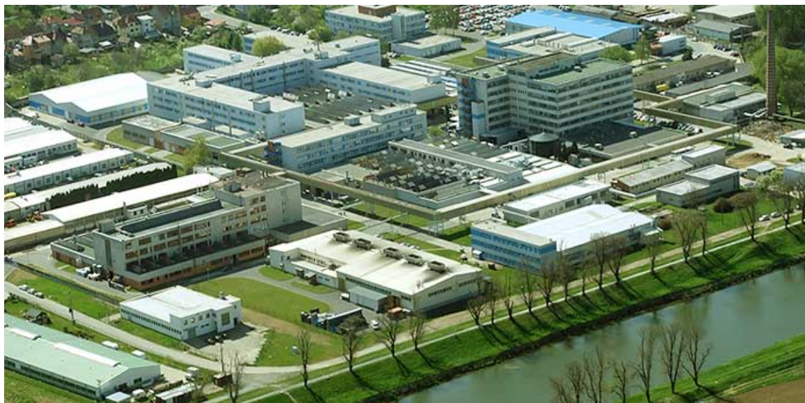
Obr. 34 Budovy společnosti MESIT holding [40]
