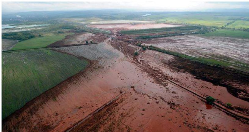
Obr. 3 Podtržená hráz skládky s toxickým odpadem [12]
