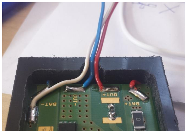
Obrázek 32: Kompletní bateriový blok
