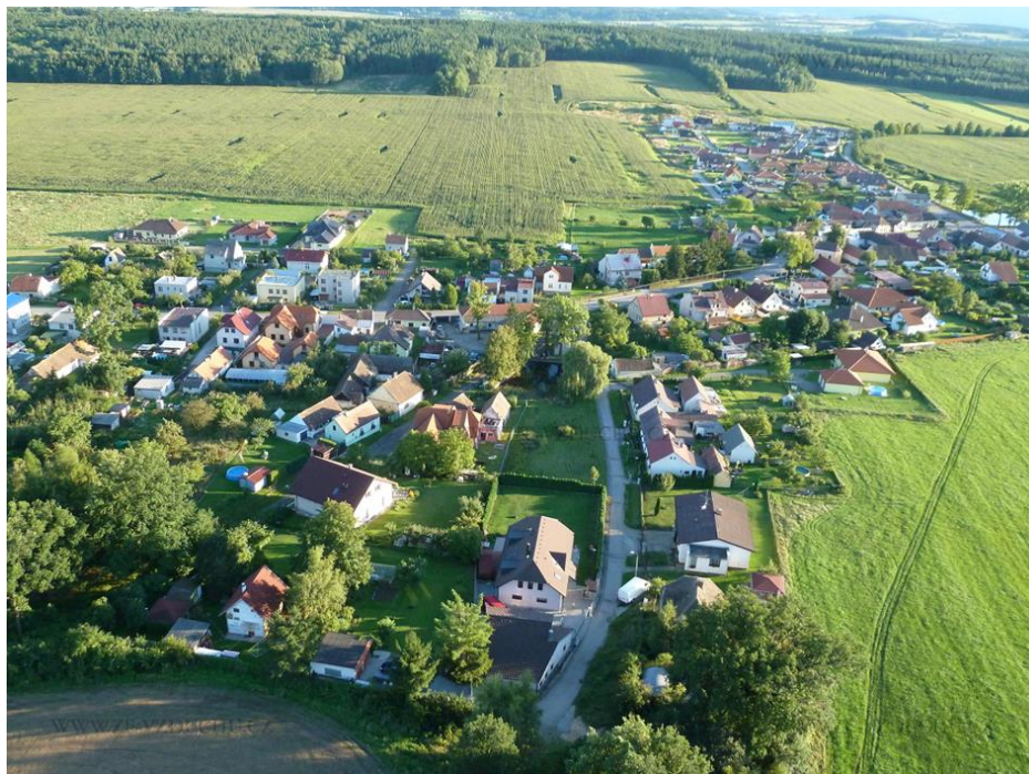
Foto 4. Suburbium Mokrý s novou výstavbou v severním výběžku intravilánu vpravo nahoře
