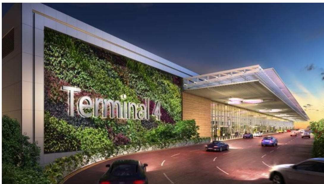
Obrázek 2.6 Terminál 4 na letišti Changi
