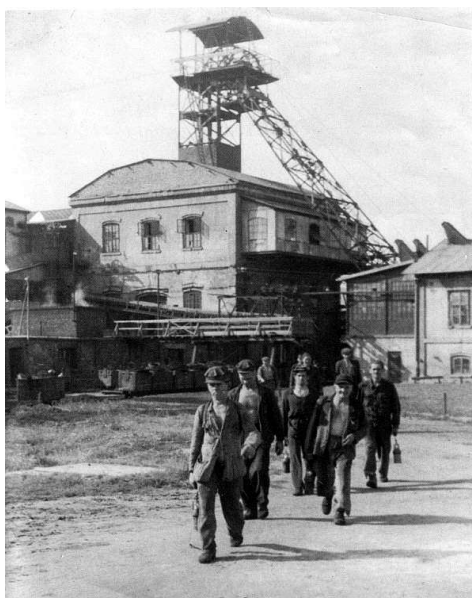
Obr. 12: Těžební věž dolu Julius III - dnešní budova technického muzea.
