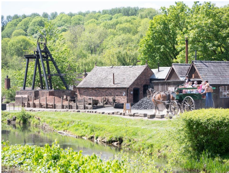
Obrázek 6 Bývalá těžní věž a dnešní muzeum ve městě Blists Hill (oblast Ironbridge). Zdroj: Ironbridge: Valley of Invention, 2024.
