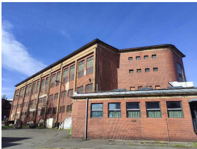
Obrázek 19 Budova Nových koupelen v DOV. Zdroj: vlastní fotografie.
