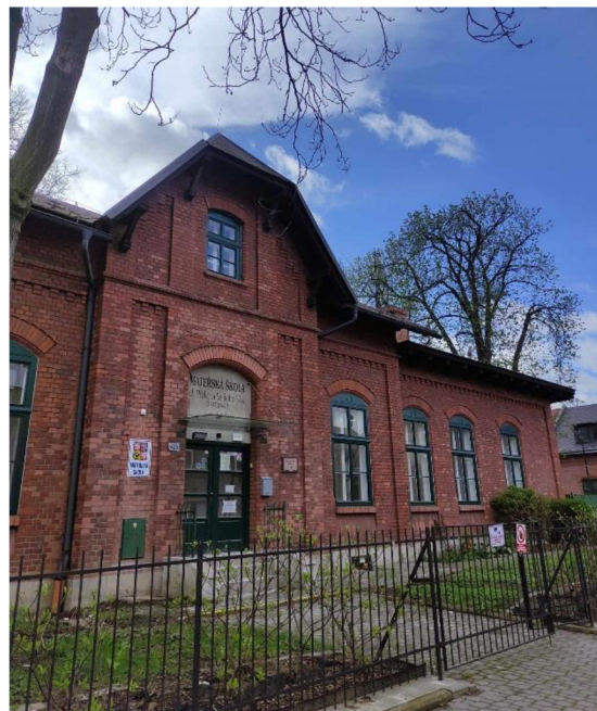
Obrázek 9 Mateřská škola vybudovaná v rámci projektu Nové Vítkovice. Zdroj: vlastní fotografie.
