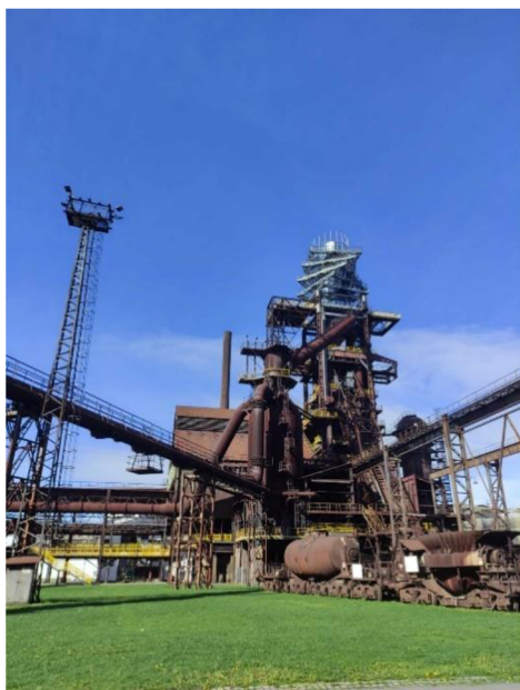
Obrázek 15 Vysoká pec č. 1. Zdroj: vlastní fotografie
