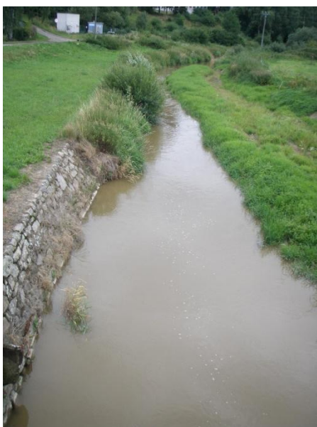
Obr.17: fotodokumentace lokality Louňovice
