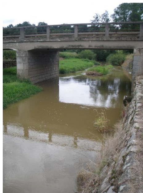
Obr.18: fotodokumentace lokality Louňovice
