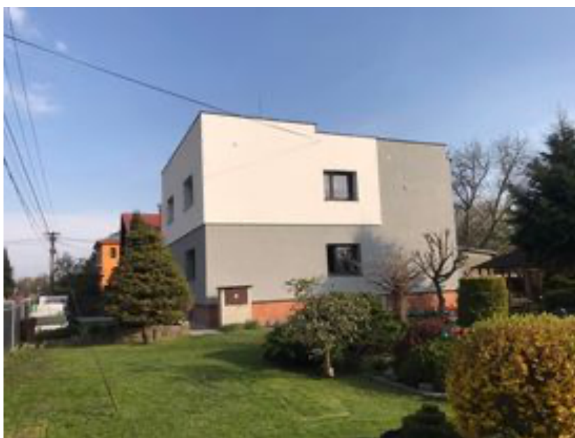
Obrázek 13 Nový stav domu pohled
