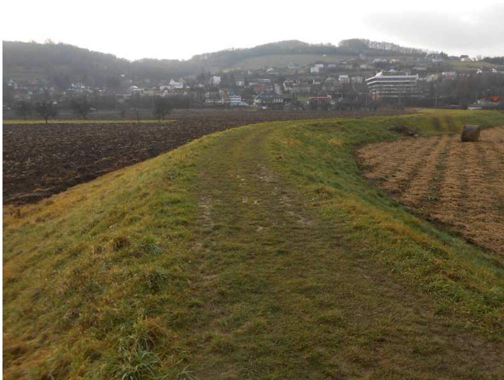
Obr. 9.1 Zemní ochranná hráz na toku Dřevnice v km 16,125
