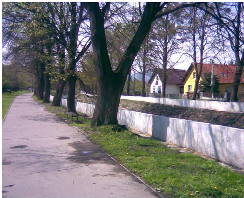
Obr. 9.2 Stabilní betonová zeď [B15]
