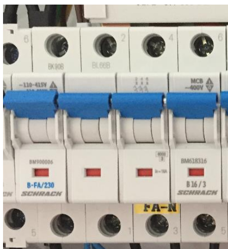
Obrázek 14: Vyrážecí spoušť u jističe nezálohované části (pořízeno v laboratoři UEEN)
