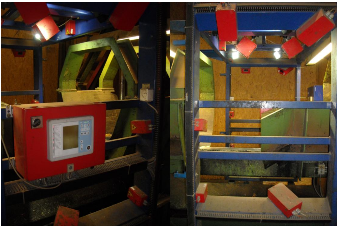
3D měření od firmy Sprecher Automation (SPRESCAN 3D-L/400).
