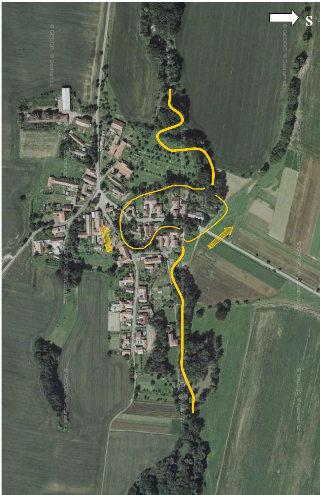
Obr.2 Ochranné povodňové koryto u obce Blížňovice
