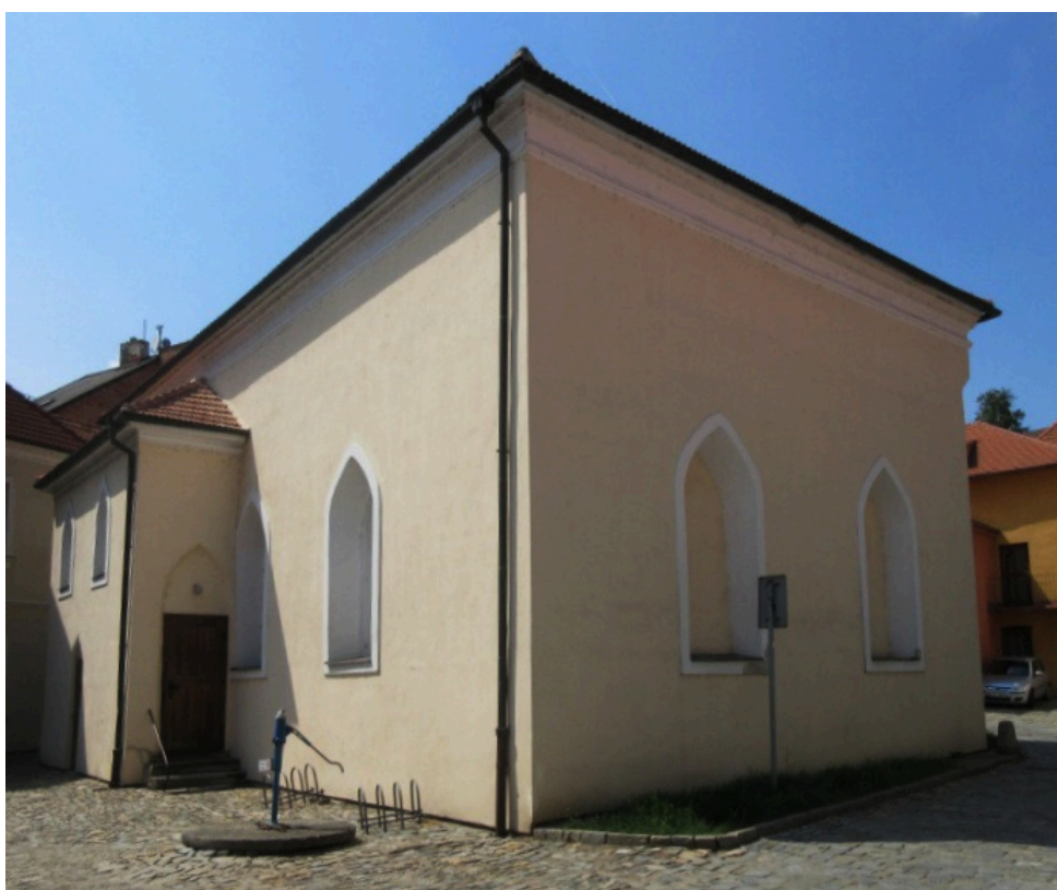
[6] Přední synagoga v Třebíči, pohled od jihovýchodu
