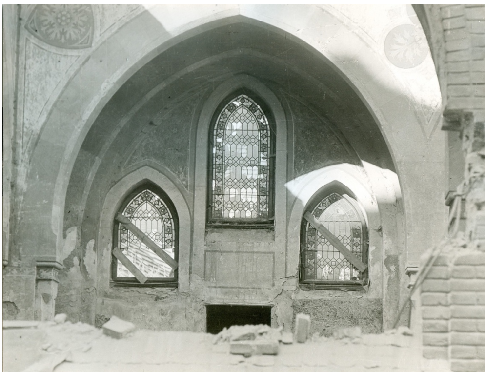
[64] Demolice synagogy v Pelhřimově, 1967, foto: V. Martínek
