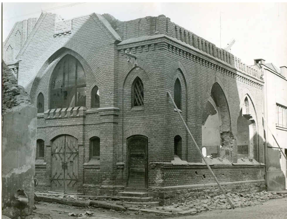
[62] Demolice synagogy v Pelhřimově, 1967, foto: V. Martínek
