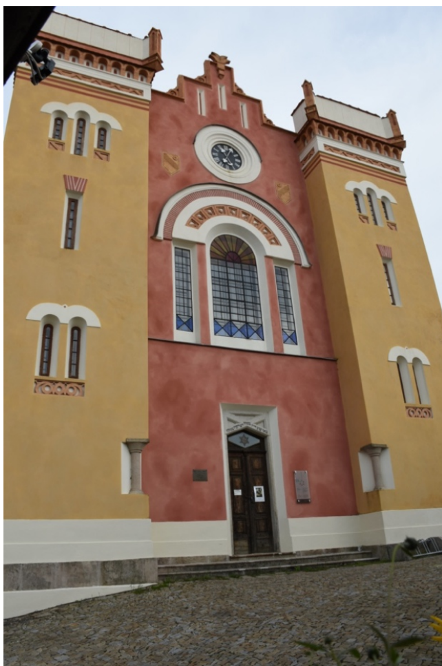
[112] Synagoga v Nové Cerekvi, průčelí
