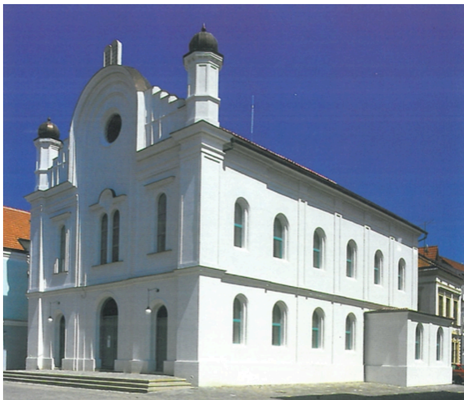
[84] Synagoga v Břeclavi, celkový pohled
