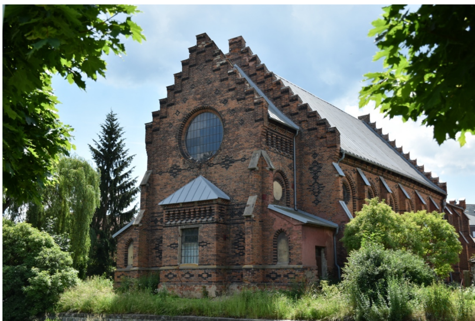
[18] Nová synagoga ve Velkém Meziříčí, pohled od severovýchodu Foto: M. Prokešová, 2020
