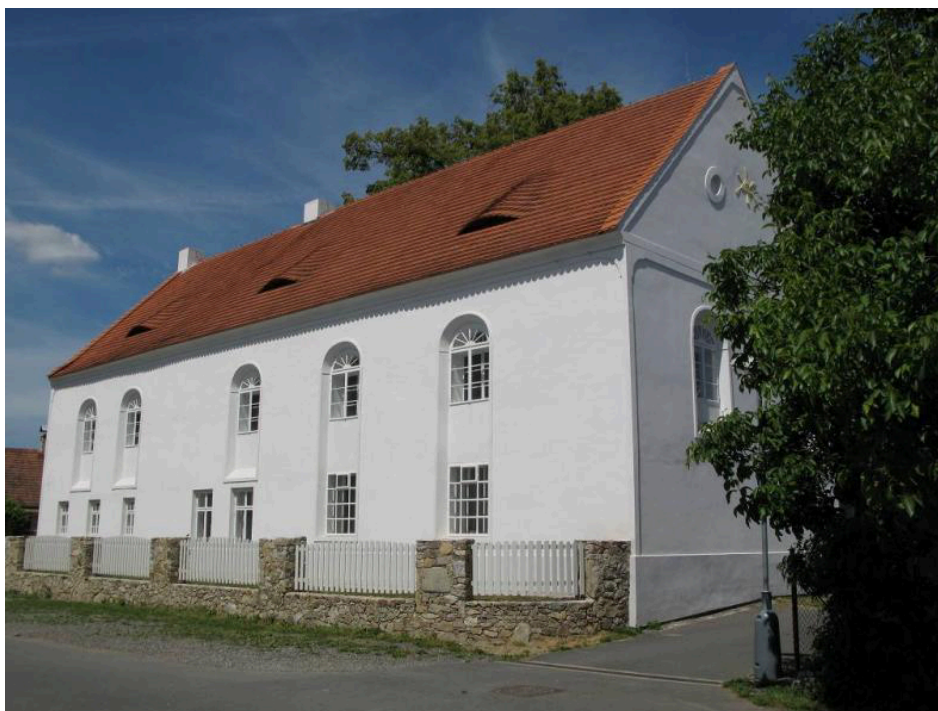
[114] Synagoga ve Čkyni, pohled od jihovýchodu
