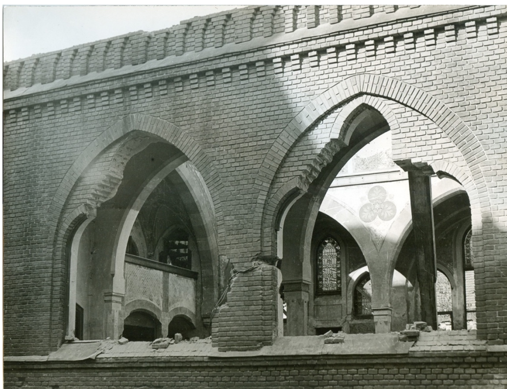
[63] Demolice synagogy v Pelhřimově, 1967, foto: V. Martínek
