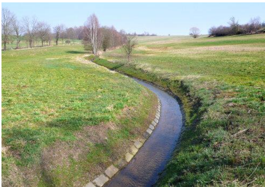
Obr. 2 Příklad upraveného opevněného potoka [3]
