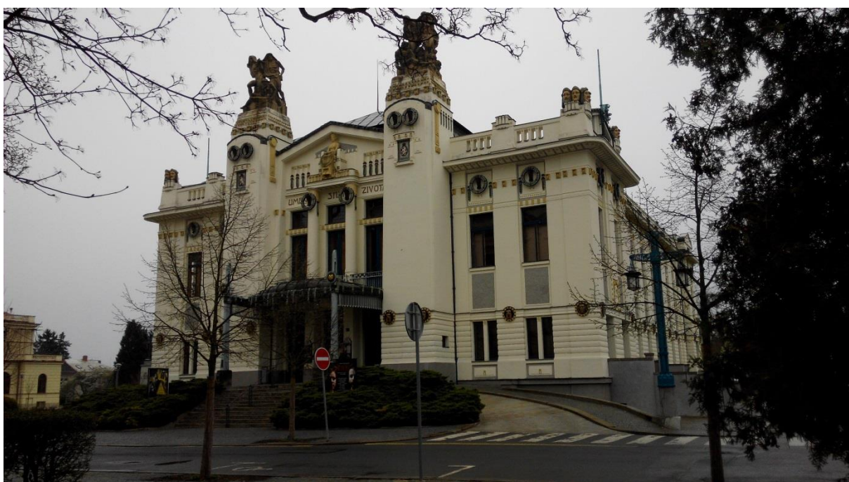
Obr. 10: Budova divadla ( zdroj: vlastní fotografie )
