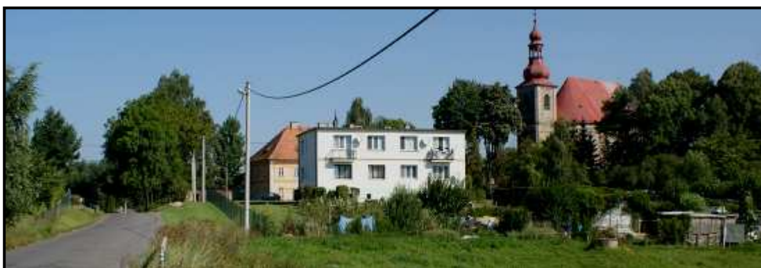
Obr. č. 16 – Necitlivé umístění bytového domu ve Verněřovicích (foto. D. Velehradský).
