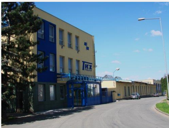
Obrázek 7: Administrativní budova společnosti TKZ Polná, spol. s r. o.
