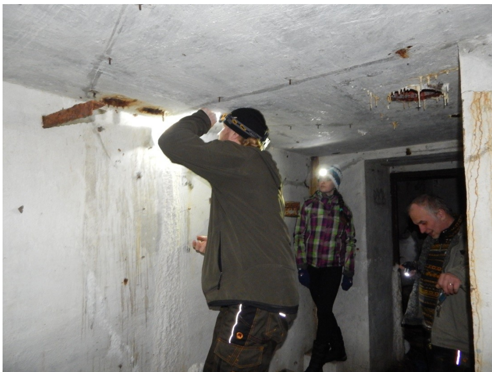
Obr.č. 43: Kontrola prostorů v bunkrech 2016
