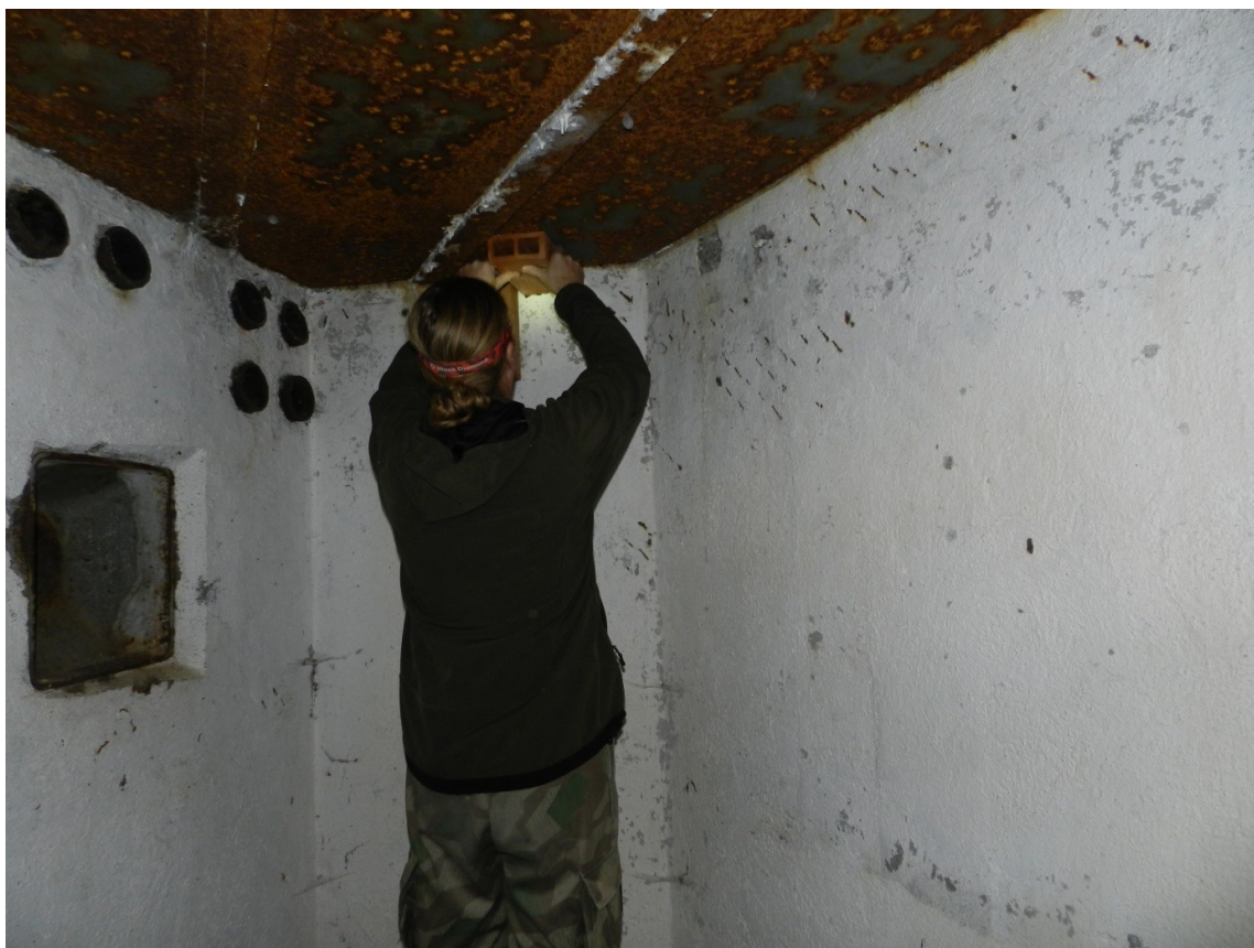
Obr.č. 46: Instalace umělých úkrytů (vodorovný typ umělého úkrytu)
