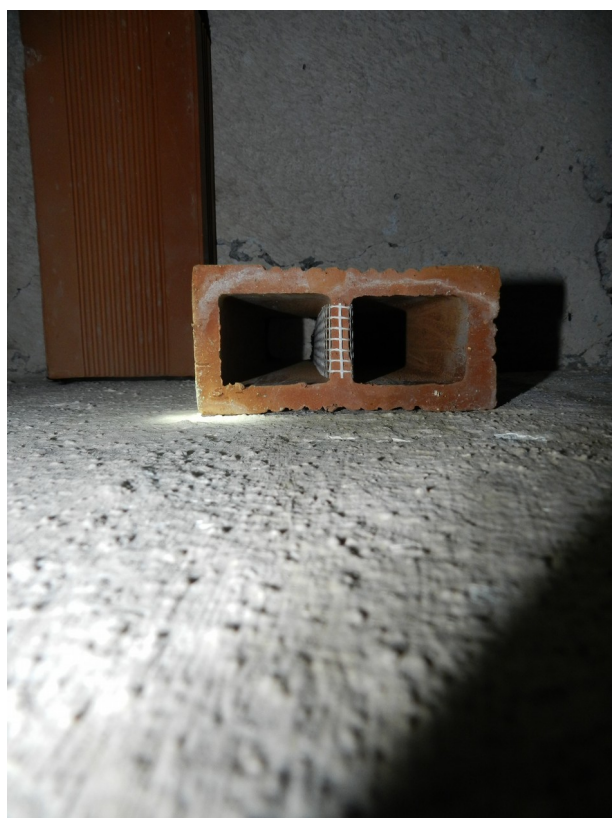
Obr.č.9: Foto vnitřku namontované svislé cihly s perlínkou.
