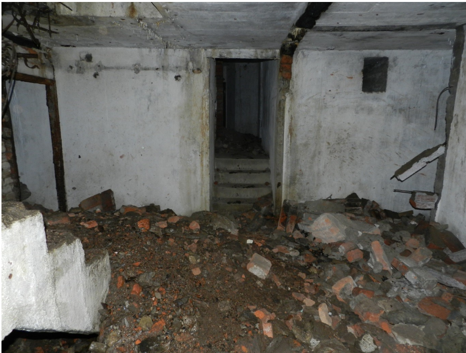
Obr.č. 50: Ukázka vnitřku objektu.
