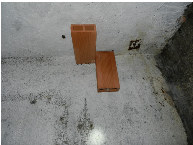
Obr.č.8: Dvojice cihel umístěné u stropu bunkru. Jedna vodorovná se stropem a druhá svislá s přítomností perlínky.
