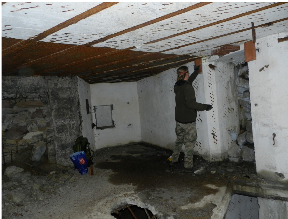
Obr.č.10: Instalace cihel v bunkru.
