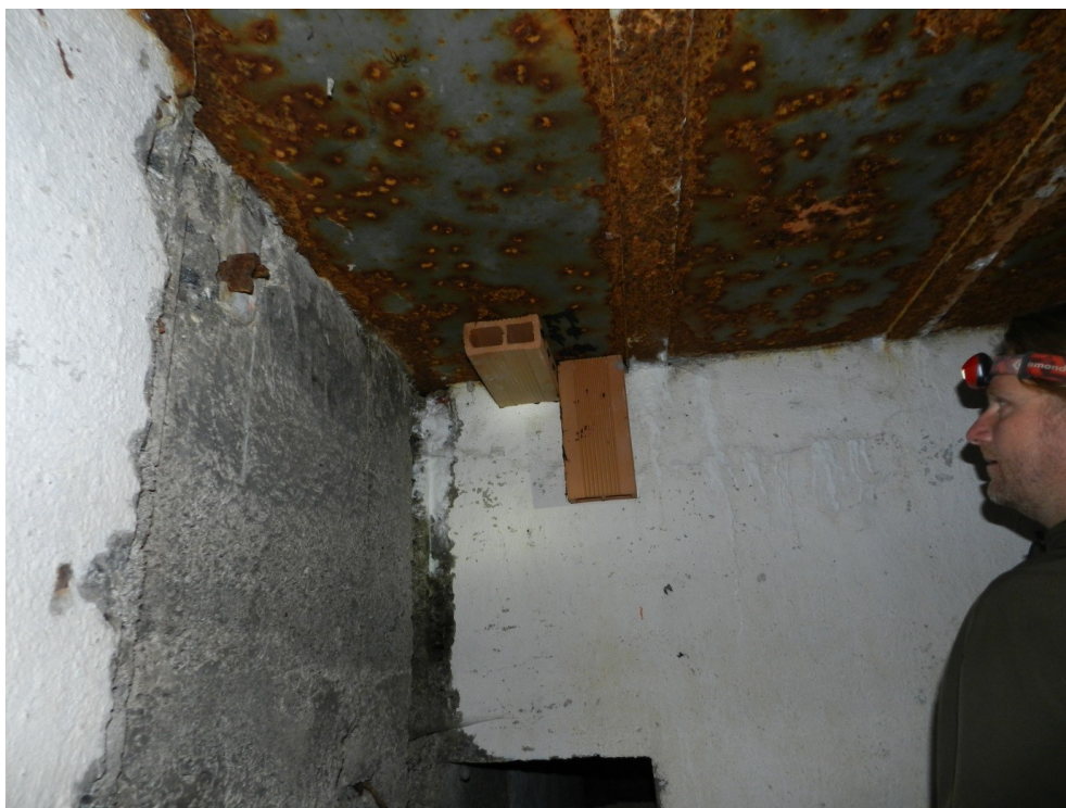
Obr.č.47: Instalace umělých úkrytů (vodorovný a svislý typ umělého úkrytu)
