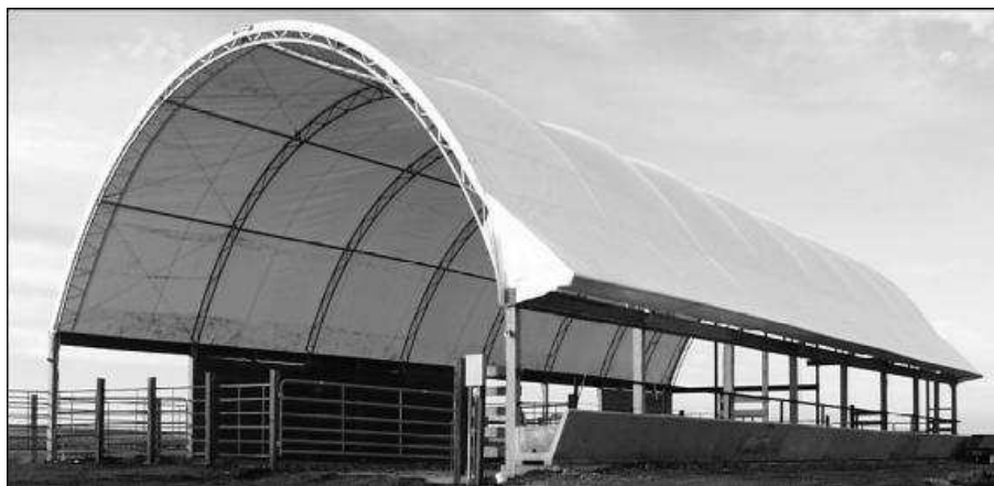
Obr. 7 Ocelová konstrukce stájí pro chov KBTPM
