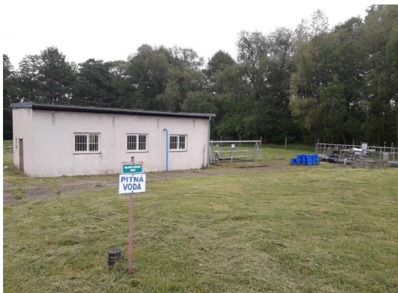
Obr. 2 - Dnes již nevyužívaná ČOV věznice Ostrov
