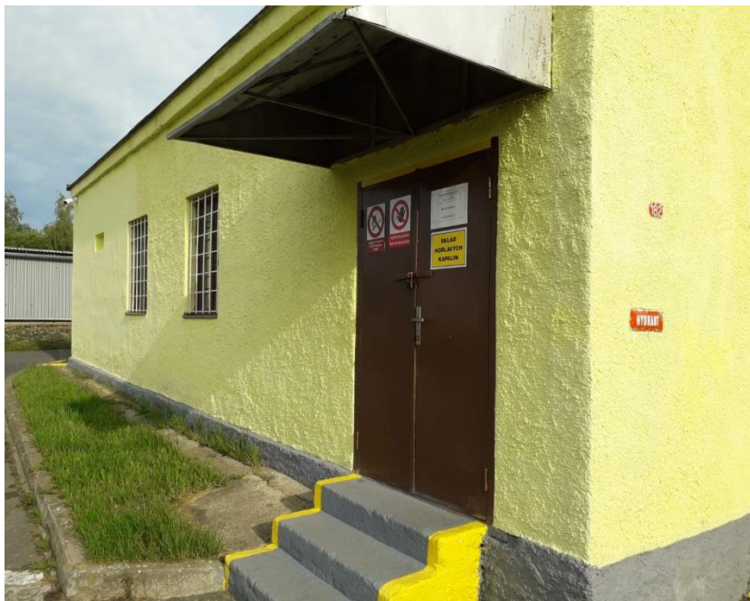
Obr. 10 - Sklad nebezpečných látek (hořlavé kapaliny)
