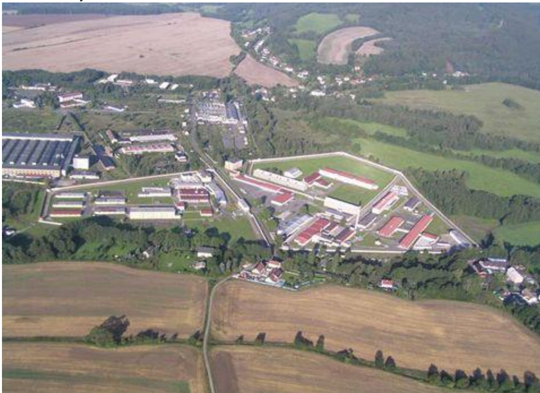
obr. 1 - Letecký snímek věznice Ostrov
