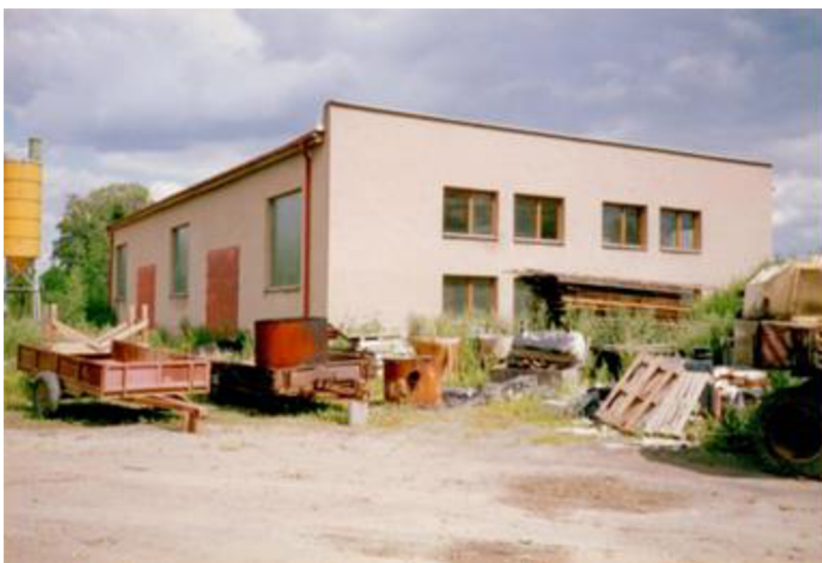
Obr. 8 Hala v Němčicích. Zdroj: Limes Litomyšl s.r.o.
