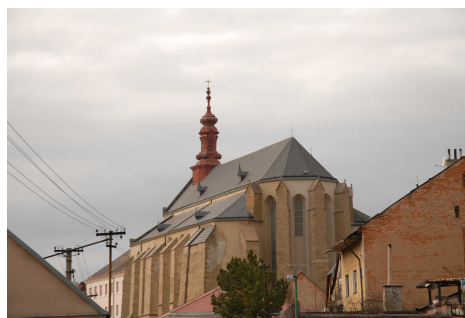
Obr. č. 8 kostel sv. Mikuláše (foto: autor)
