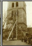
Zvonice v roce 1897, kdy byly umístěny do staré zvonice zvonů
