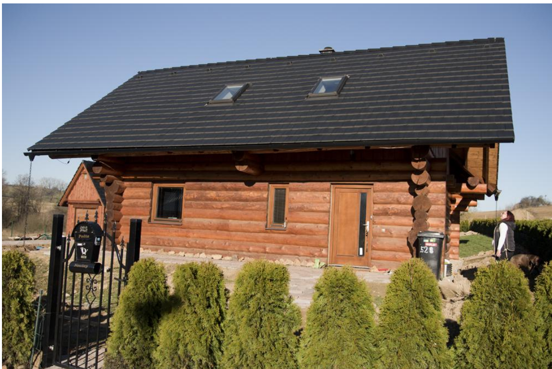
Obrázek 1 - Srub postavený v roce 2016 firmou T.M.T. srub s.r.o. v obci Štoky, kraj Vysočina (vlastní foto)
