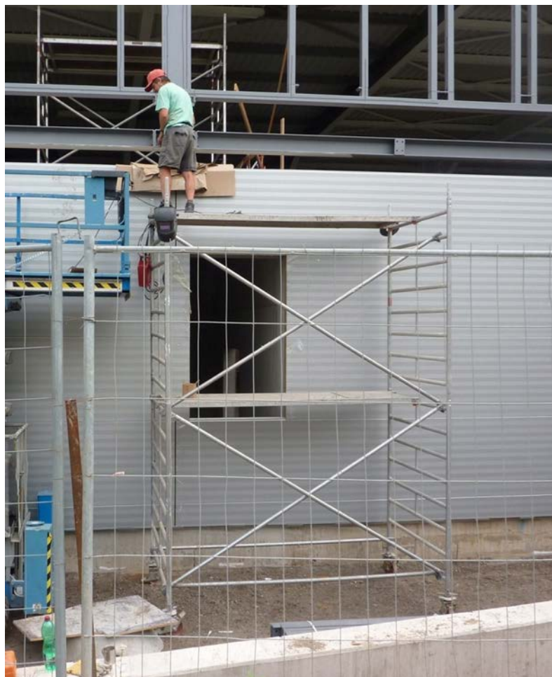
Obr. Pojízdné lešení na staveništi
