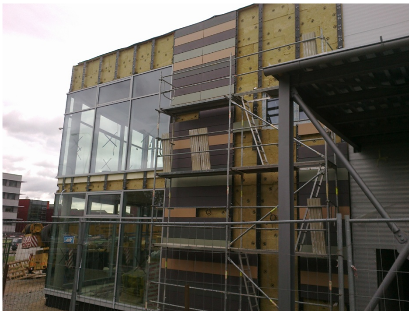
Obr. Montáž keramických desek
