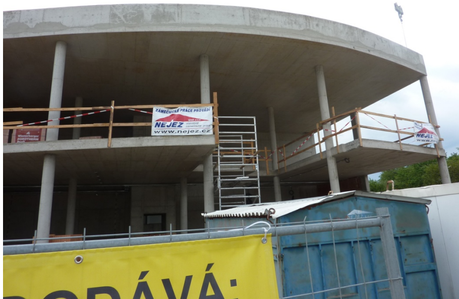
Obr. Provizorní dřevěné zábradlí
