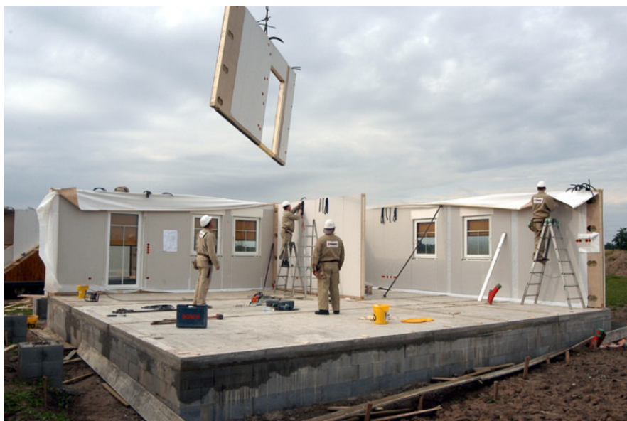
Obr. 8: Výstavba sloupkové dřevostavby z prefabrikovaného systému. Zdroj: Haas Fertigbau Chanovice s.r.o., 2016.
