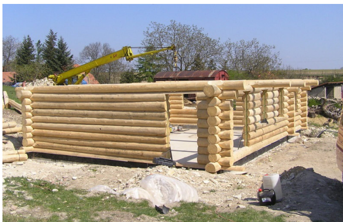
Obr. 6: Výstavba srubového domu. Zdroj: Haniš, 2016.
