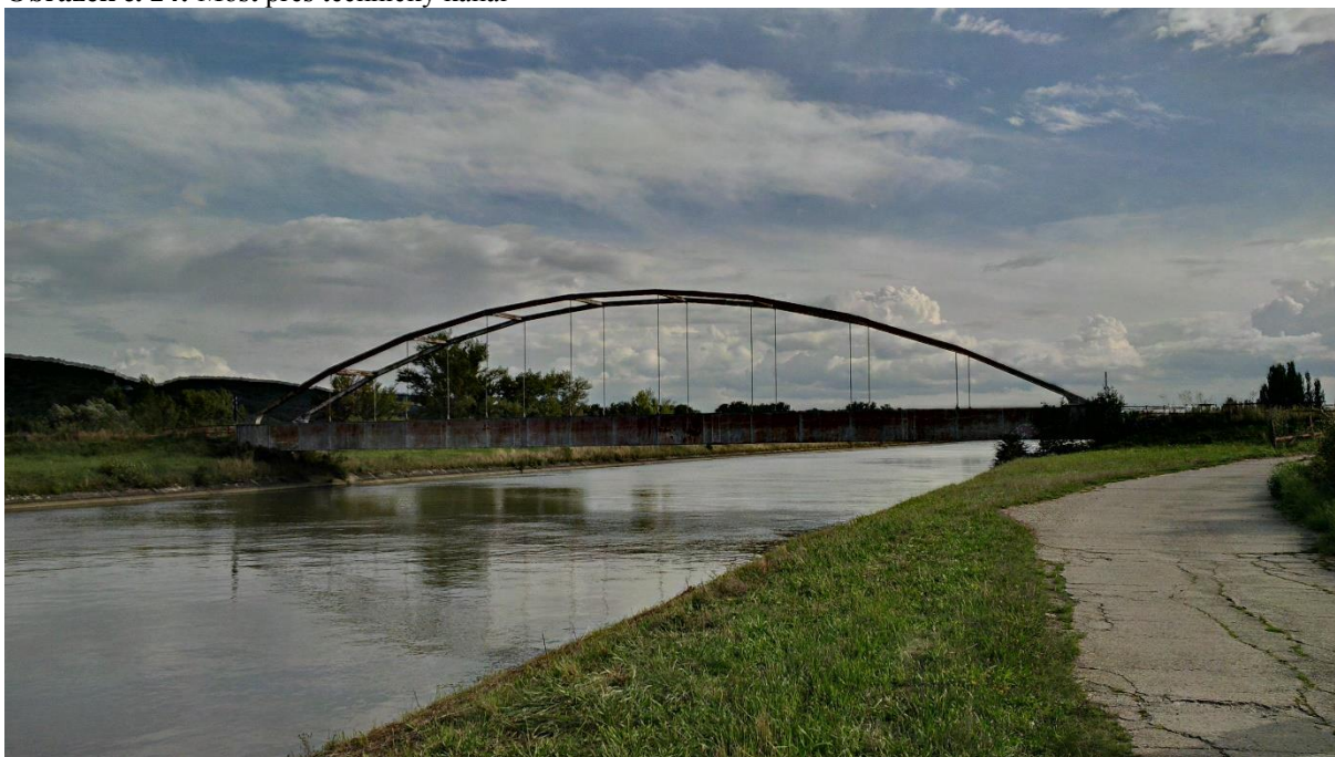
Obrázek č. 24: Most přes technický kanál
