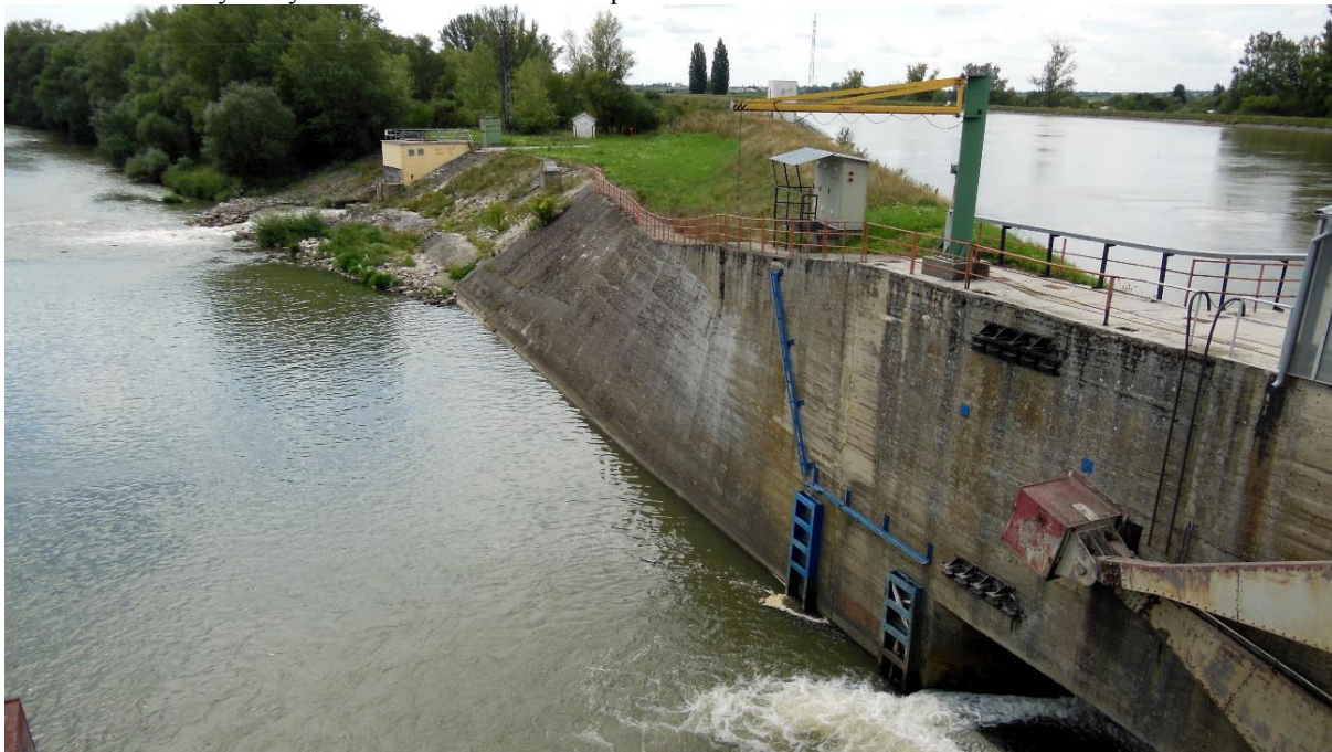
Obrázek č. 23: Výškový rozdíl mezi zahloubením přírodně blízkého a technického toku
