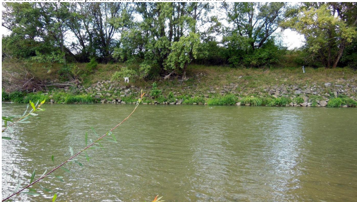
Obrázek č. 13: Zpevnění pravého břehu přírodě blízkého toku balvany
