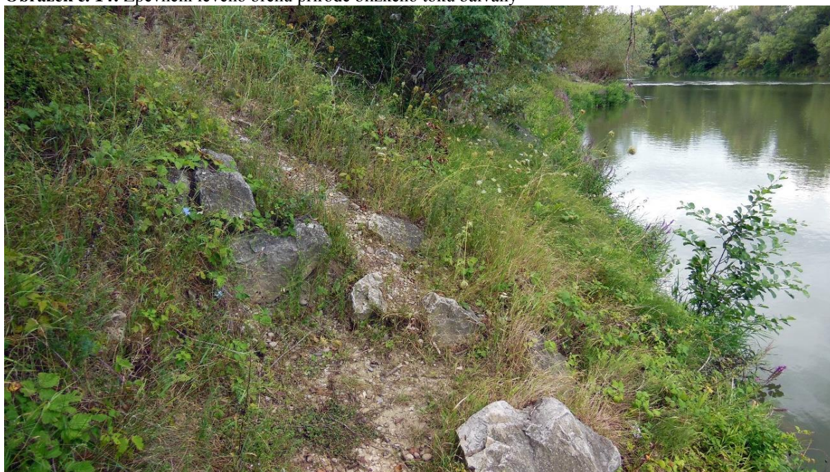
Obrázek č. 14: Zpevnění levého břehu přírodě blízkého toku balvany
