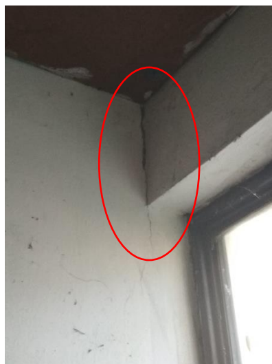
Obrázok 4.2 Vlásočnicové trhliny
