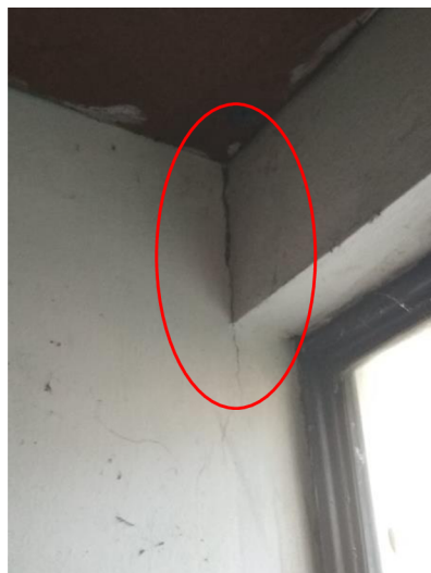
Obrázok 4.2 Vlásočnicové trhliny
