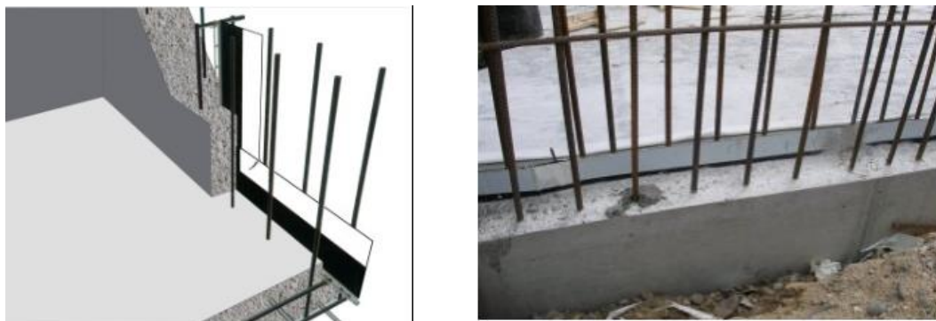
Obrázek 8, 9 - Osazení bitumenového plechu [9]
