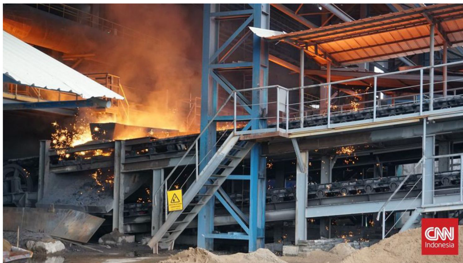
Obr. 6) Požár pece niklové hutě společnosti Indonesia Tsingshan Stainless Steel [36]
