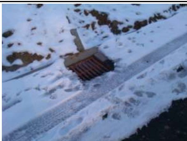
Č. fot. 7, dešťová kanalizace
