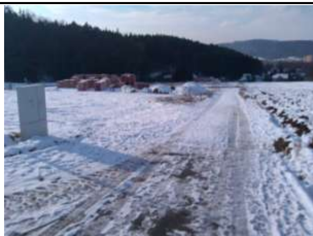
Č. fot. 33, doposud nedokončená komunikace
