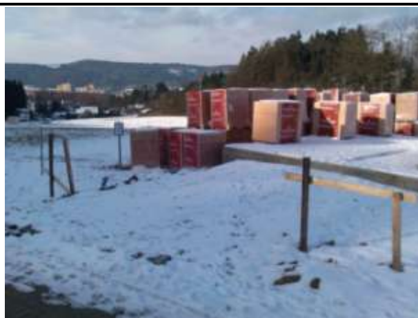
Č. fot. 10, probíhající stavba RD
