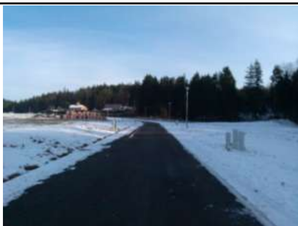
Č. fot. 5, asfaltová komunikace
