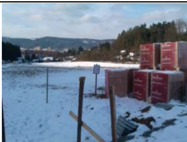
Č. fot. 9, probíhající stavba RD
