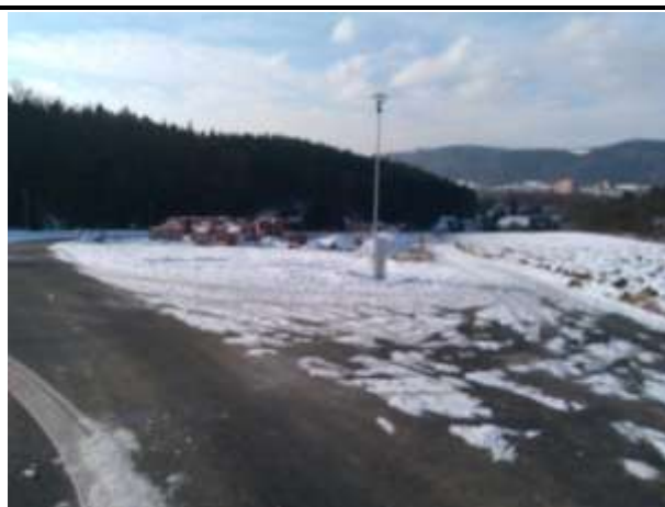
Č. fot. 12, asfaltová komunikace
