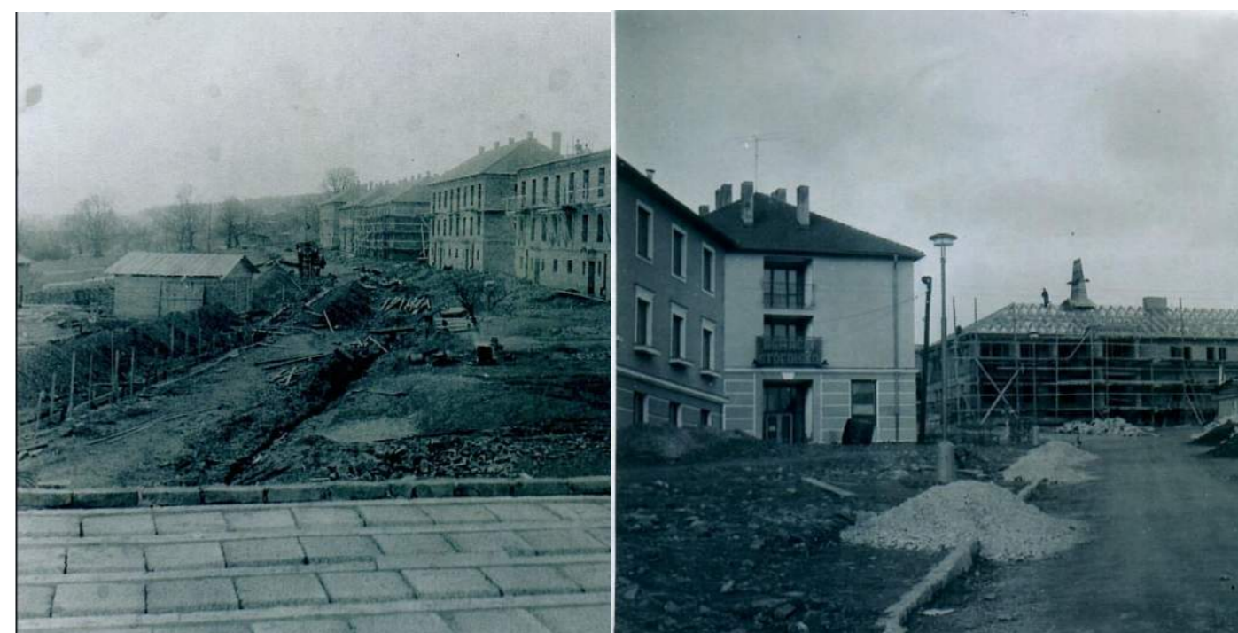
Obr. č. 22 Historické fotky z výstavby sídliště v 50. letech 20. století
