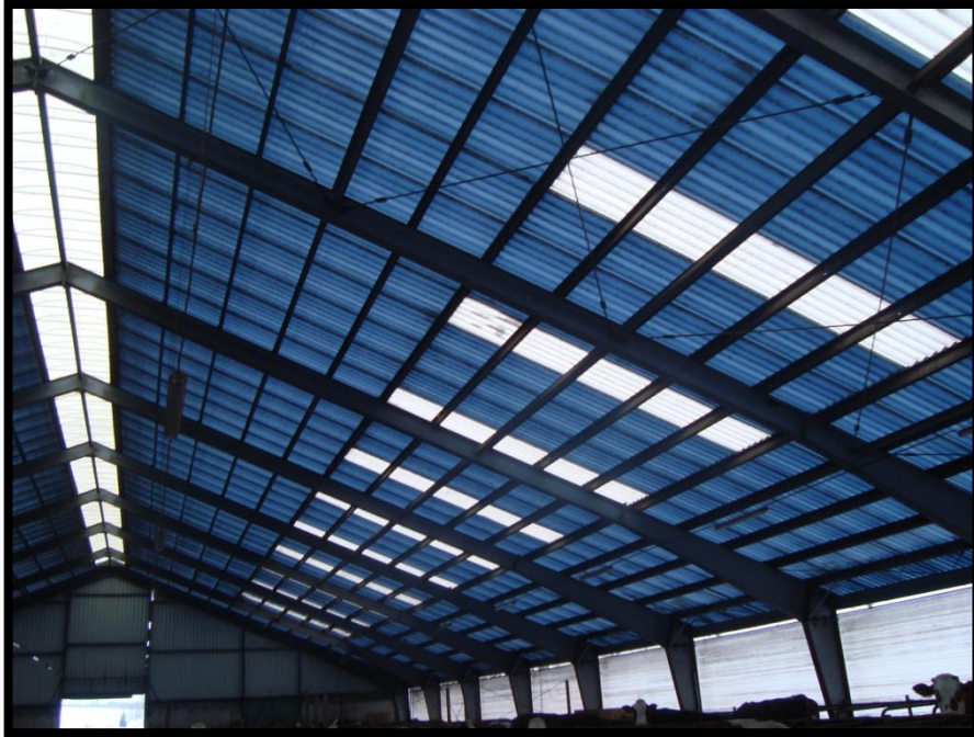
Obr. 1.5: Pohled na osvětlovací soustavu ve stáji
