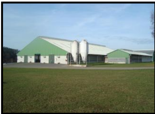
Obr. 1.1: Pohled na stáj s dojírnou
