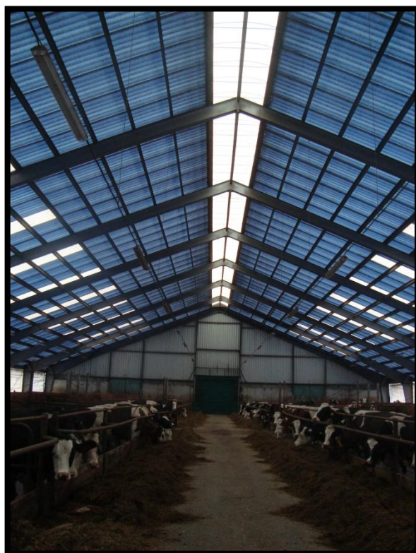
1.2: Interiér stáje při denním osvětlení
