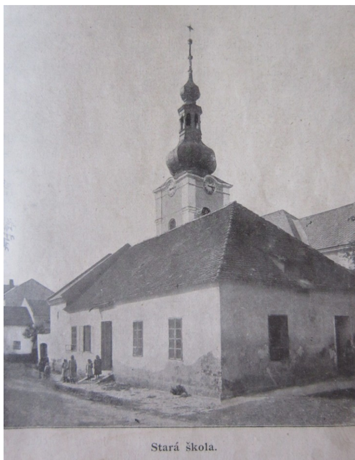
Příloha č. 7 – Pohled na starou budovu školy z roku 1908.
