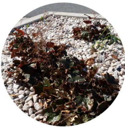
Obr. 14 Nevhodné použití dlužich na parkovišti v Říčanech
