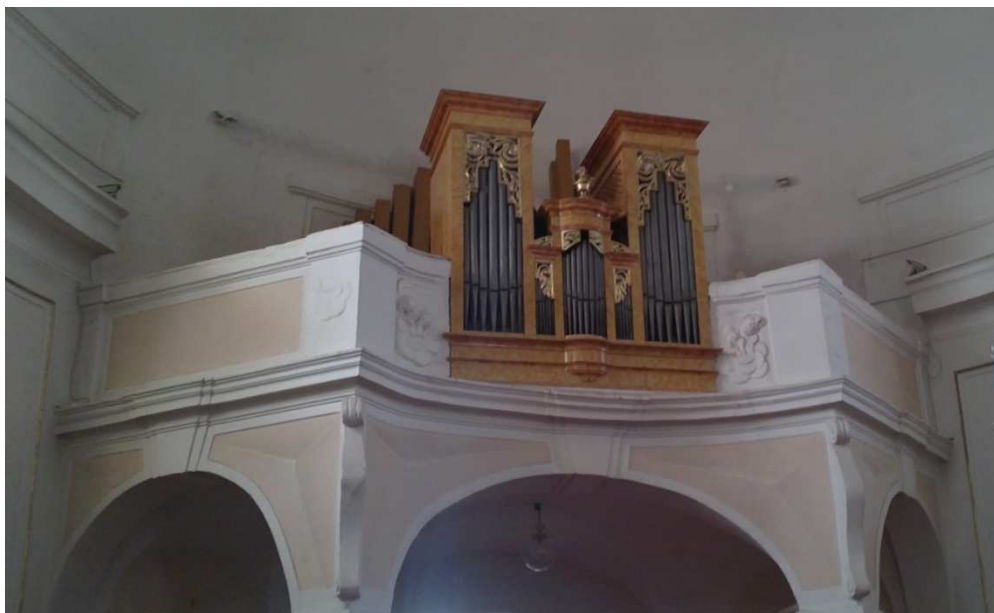
Obr. 11: Pohled na vyvýšený kůr s varhanami v zadní části kostela (zaměřeno v rámci 2. nadzemního podlaží)
