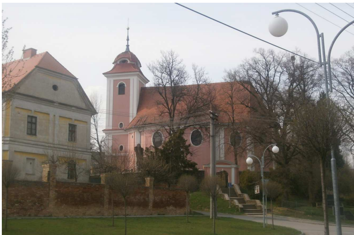
Obr. 2: Kostel sv. Mikuláše s budovou fary
