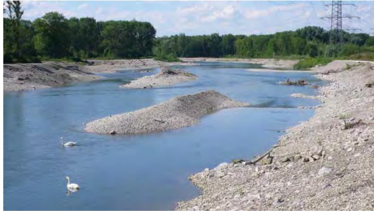
Obrázek 13: Štěrkové hroudy po přemístění po vytěžení ze stran koryta. Je počítáno s jejich postupným rozplavováním po řečišti a obohacování tak toku o splaveniny (Just 2014).
