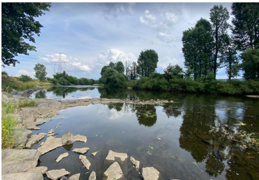
Obrázek 18: Opevnění levého břehu kamennou rovnaninou, s kamenným výhonem.
