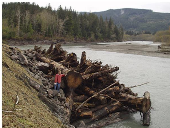
Obrázek 9: Zátarasa z kmenů na břehu řeky Hoh chránící důležitou silnici (Hall et Moler 2006).
