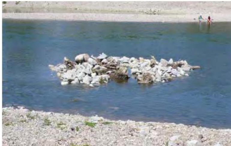
Obrázek 14: Struktura z kamenů a pařezů k přispění tvarové členitosti koryta a nabídce stanovišť (Just 2014).
