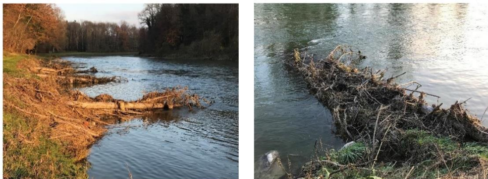
Image 13: Wooden groynes (Neuhaus et Mende 2021).
