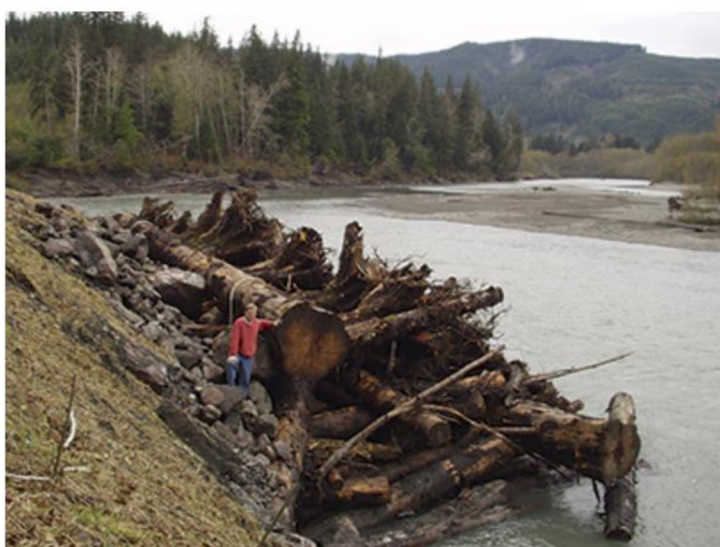
Obrázek 9: Zátarasa z kmenů na břehu řeky Hoh chránící důležitou silnici (Hall et Moler 2006).
